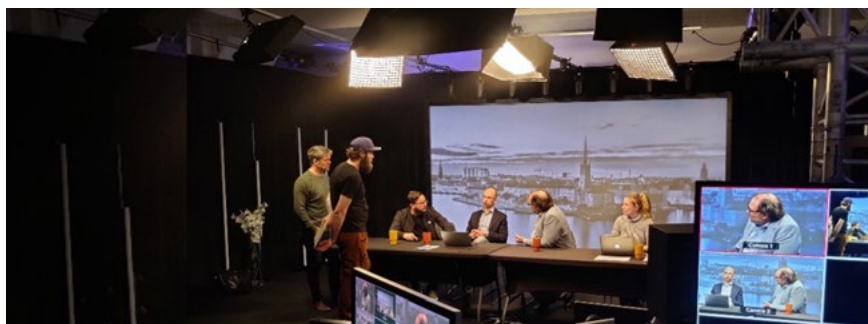
Bild 4: Exempel från en webbsändningsstudio. Lägg märke till belysningen som är monterad i taket.
